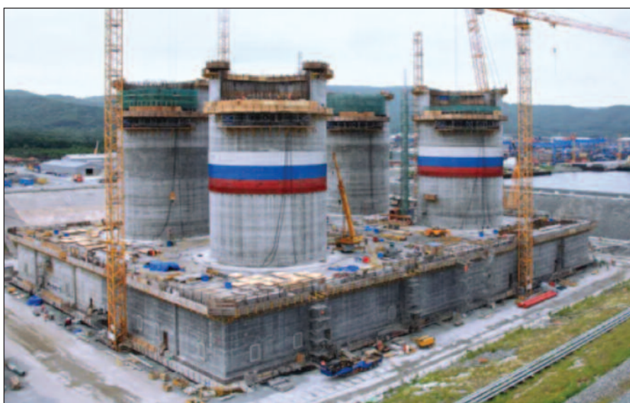
BUNNFAST: Sakhalin 1 betongpøttform under bygging ved Kværners byggedokk i Vladivostok. Plattformen måler 130x100 meter i grunnflate. skaftene er på 40 meter. Fra bunn til topp av sjaft blir det 55 meter. Kværner
