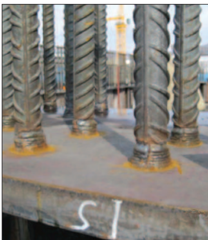
Detaljer fra armeringssveisingen som ble utført på Shakalin.
