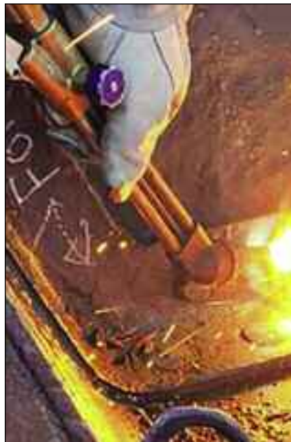
Odin viser hvordan man brenner av en nagle. Varmer den først i en side og deretter pendle med brennespissen rundt på naglen for å vaske vekk metallet. Man kan også starte i senter av naglen. Når hodet på naglen er brent bort slår man naglen ut med hammer og nagledor.
