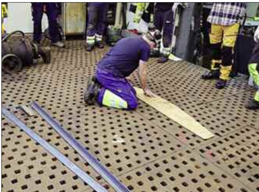
På bildet ser vi at Werner bruker en tynn Huntonit plate til oppmerking av spantet. Dette er en mal som er en nøyaktig kopi av spantet som skal erstattes. Man tegner opp en strek på gulvet slik at man har formen på spantet.
