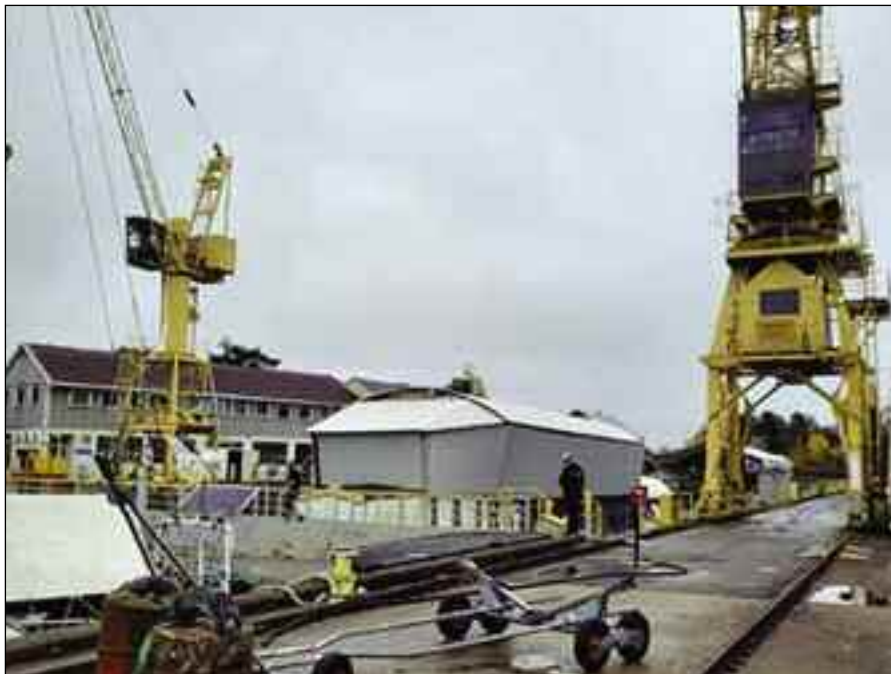
Bredalsholmen Dokk og Fartøyvernssenter etablert i 1876 og var den største sivile dokken i landet. Det ble etablert kranbane med dampdrevet kran langs nordlige dokkside på Bredalsholmen under andre verdenskrig. Til venstre er kran 8 som står på den nordlige kranbanen og til høyre er kran 24 som står på den sørlige kranbanen og ble kjøpt inn i 1958. Kran 8 har gjennomgått flere ombygninger i sin historie mens Kran 24 er relativt uforandret. Dette er en portalkran som er av klinket fagverkskonstruksjon bygget for britiske Ministry of Supply av Stothert & Pitt Ltd. i 1944.
